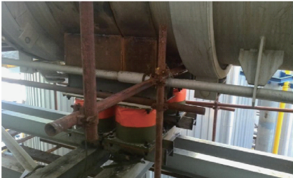
(a) 拉杆补偿器处阻尼器安装
