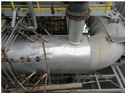
图 5 管道周向小管布置
